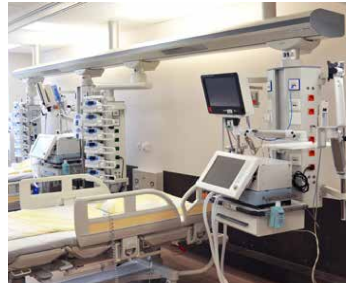
Abb. 072 | moduflex nova mit indirektem Licht St. Vincenz-Krankenhaus Limburg, Deutschland
